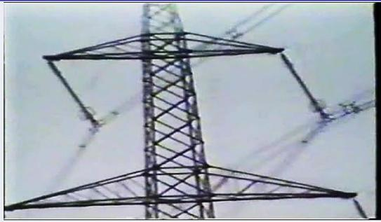
Die Konstruktion verringert die Amplitude und die Intensität des Seiltanzens und führt zur Selbstdämpfung der Schwingungen
