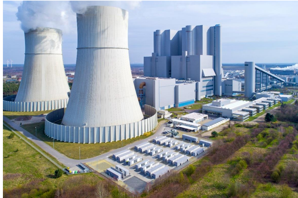
Kraftwerk Schwarze Pumpe mit BigBattery Lausitz
